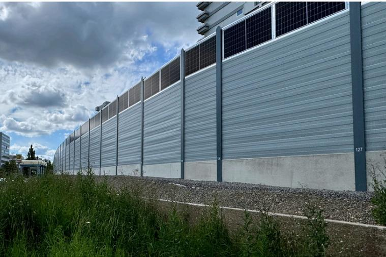
Volta® Opak als senkrechter Aufsatz auf Aluminiumwand
