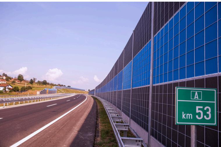
Lärmschutzwand mit Volta® Opak - Vorderseite (absorbierend)
