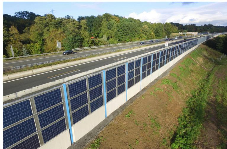
Lärmschutzwand mit Volta® Opak - Rückseite
